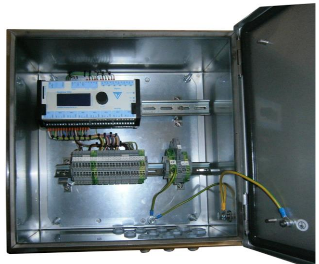
COMBILOG 1022, eingebaut in Edelstahlgehäuse Typ 9930.1000
